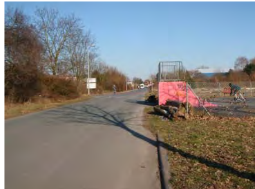
Abbildung 20: Braunshardt Büttelborner Weg (Mangel 11), beidseitig fehlende Gehwege, unmittelbare Nähe zum Schulzentrum und zu mehreren Sport- und Freizeitstätten
