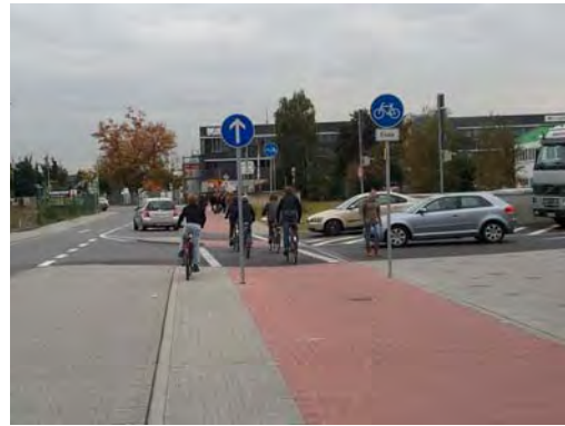
Abbildung 27: R.-Koch-Straße (Mangel 17) Abbildung 28: Gutenbergstraße (Mangel 19) Breite, stark frequentierte Grundstückszufahrten, Gefährdung des Rad- und Fußgängerverkehrs da deren Vorrang häufig durch Kfz-Verkehr missachtet wird
