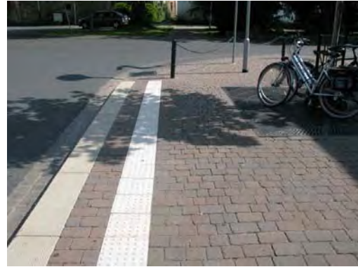
Abbildung 8: aus Noppenplatten ausgebildeter Blindenleitstreifen an der Haltestelle Weiterstadt-Gräfenhausen Postplatz
