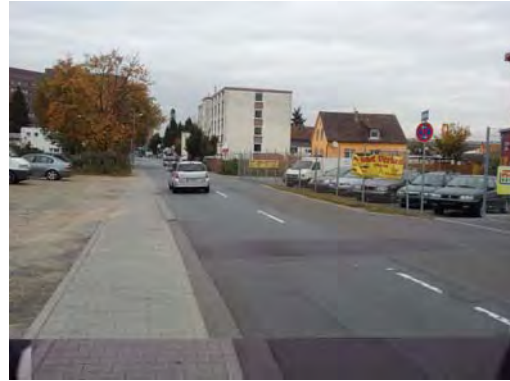
Abbildung 22: Riedbahn Waldstraße (Mangel 20), einseitig fehlender Gehweg, gegenüberliegender Gehweg zu schmal, hohe Kfz-Verkehrsmengen
