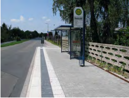
Abbildung 7: ordnungsgemäßer barrierefreier Ausbau der Haltestelle Weiterstadt-Riedbahn Riedstraße mit Rillenplatten als Blindenleitstreifen
