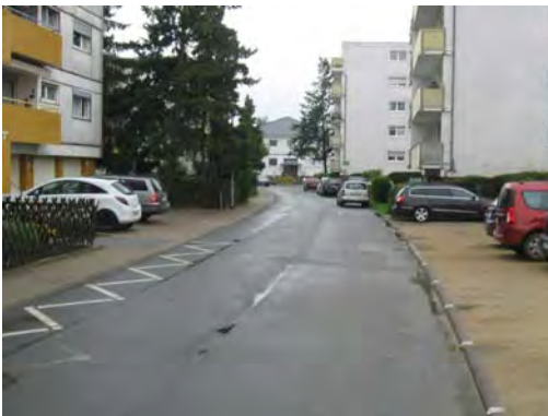
Abbildung 19: Schneppenhausen Lessingstraße (Mangel 6), einseitig fehlender Gehweg im Wohngebiet (Tempo 30-Zone)
