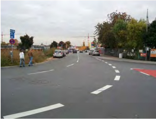
Abbildung 21: Riedbahn Am Dornbusch (Mangel 18), einseitig fehlender Gehweg, hohe Kfz-Verkehrsmengen, keine Querungshilfen
